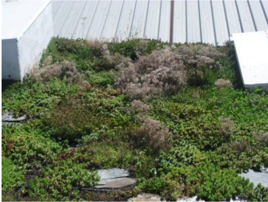
Estado actual de las especies utilizadas en la cubierta vegetal
