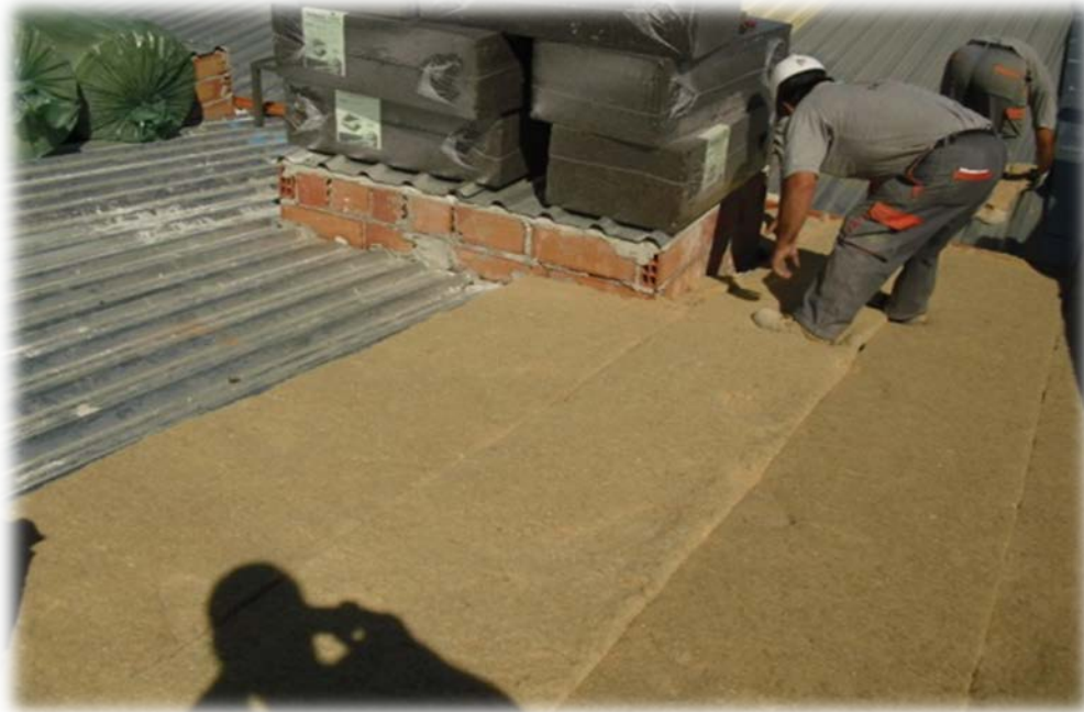
Colocación de capa de cáñamo sobre la superficie metálica original
