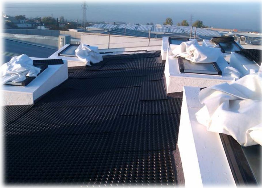
Resultado de la instalación de capa drenaje
