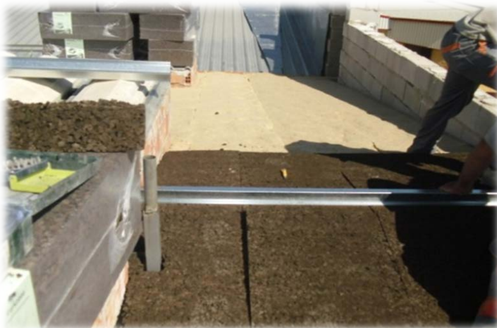
Instalación de capa de corcho natural sobre la superficie de cáñamo subyacente
