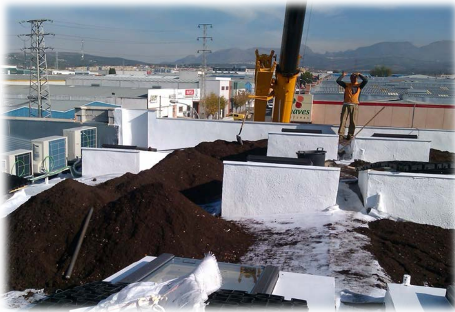
Instauración de capa de sustrato especial de cubiertas extensivas
