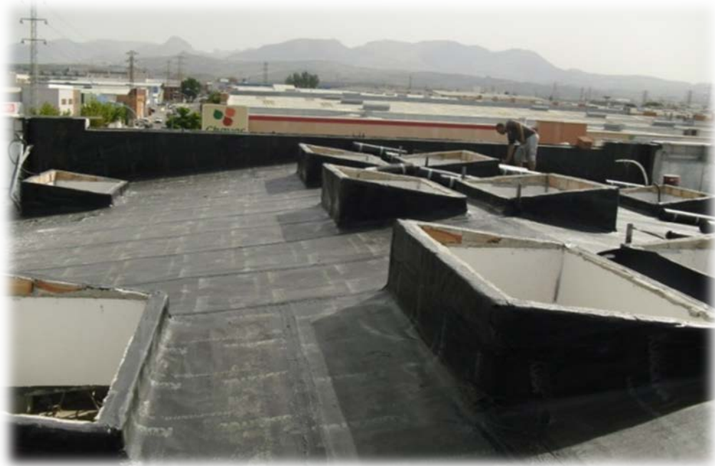
Impermeabilización de la cubierta mediante diferentes capas asfálticas
