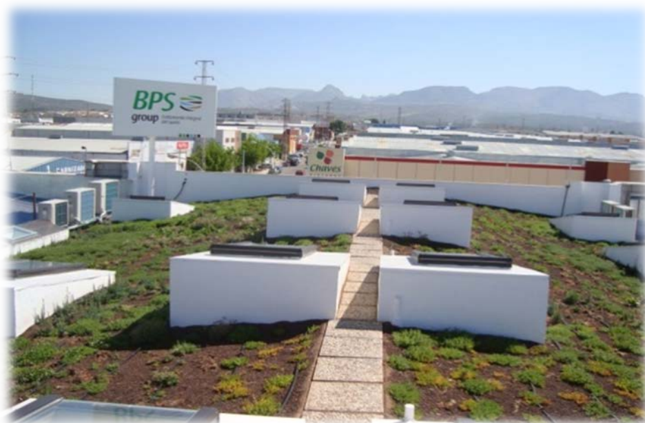
Estado inicial de la instalación de la cubierta vegetal en la sede de BPS Group
